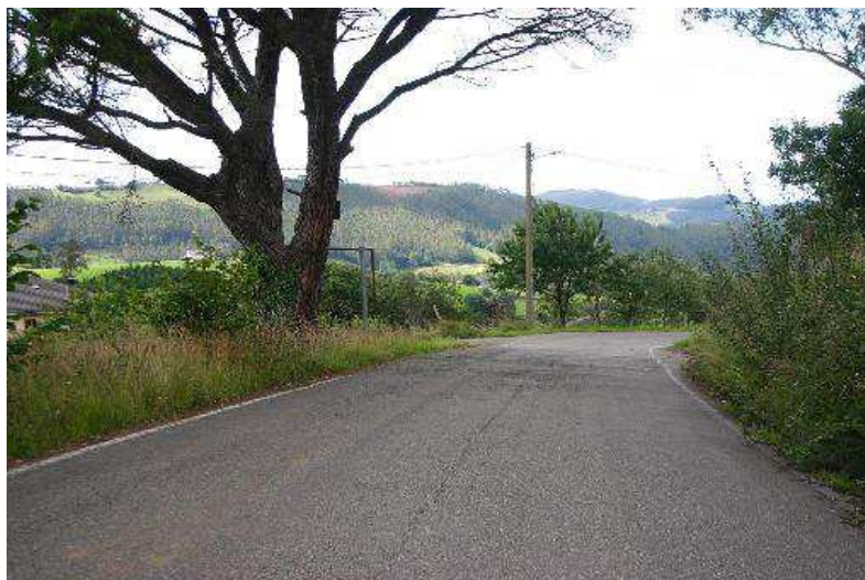
Vista P.K 2.300 T.C Coba en sentido contrario al tramo
