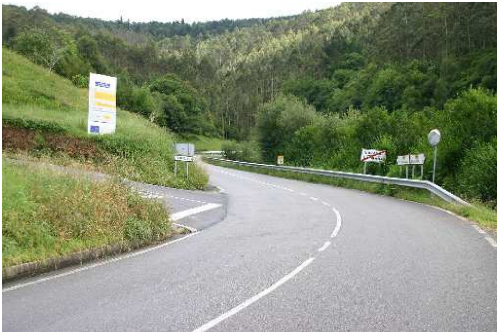
Vista entrada acceso viniendo desde La Caridad.
